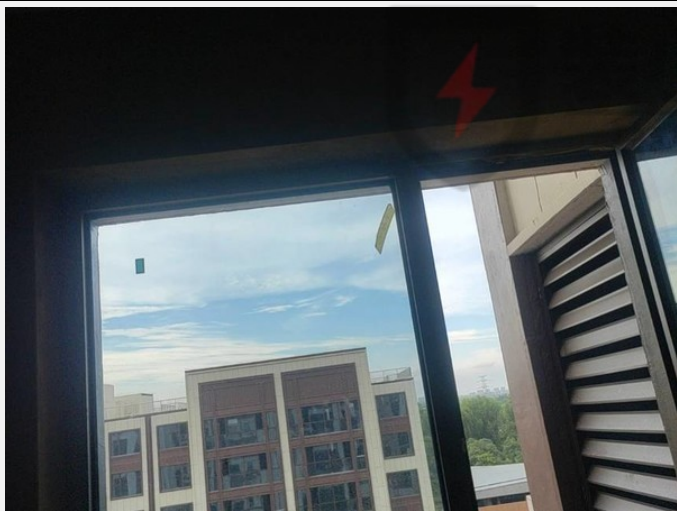
1、窗户玻璃压条对缝不平
