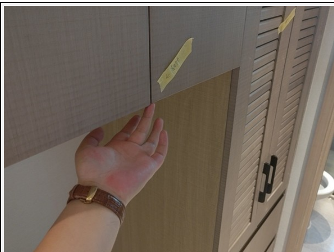
2、洗衣机柜门扇对缝底边不平
