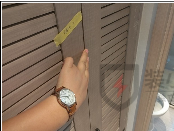
3、洗衣机柜门扇对缝不平
