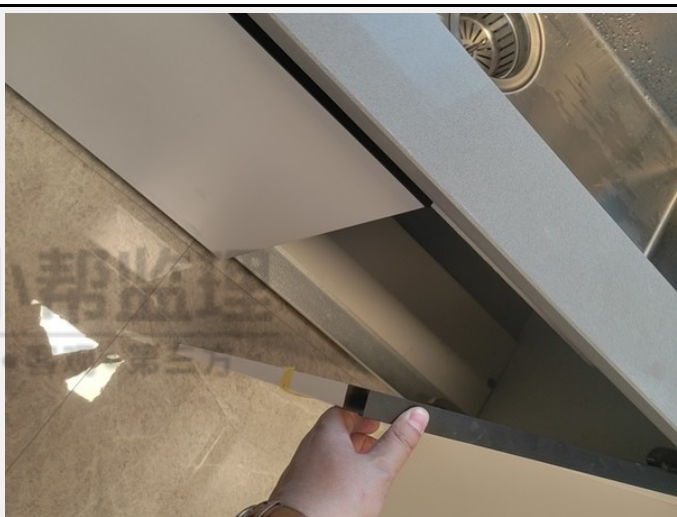
2、洗菜盆下方门扇内测破边
