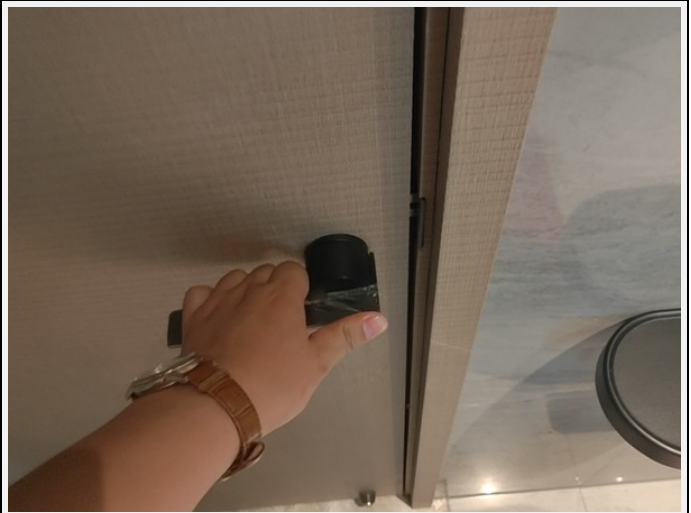
4、木门关闭后间隙过大
