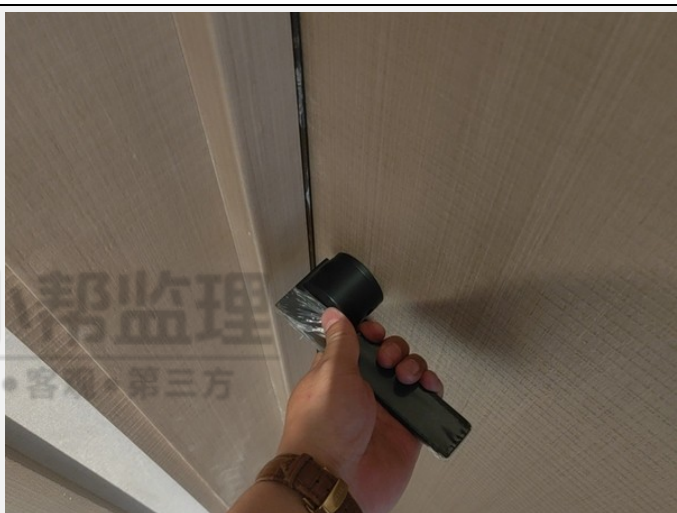
4、木门关闭后间隙过大
