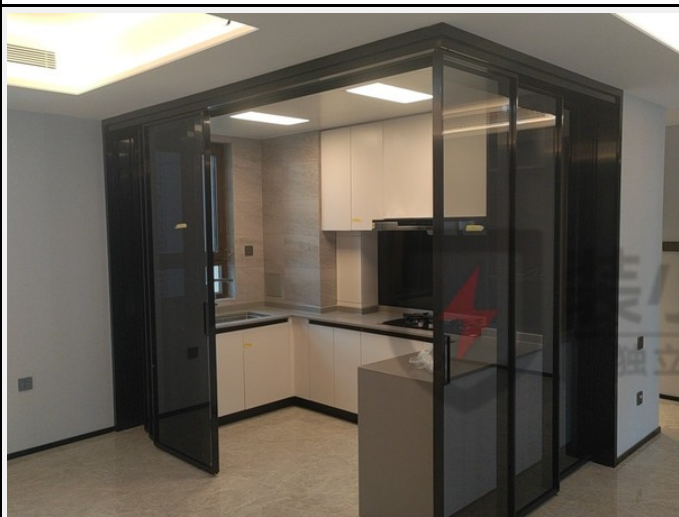
1、推拉门下方固定轮未安装，晃动幅度较大
