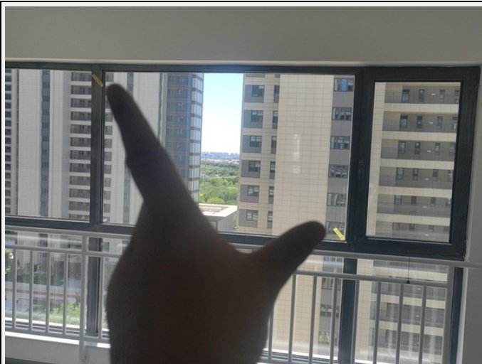
3、阳台窗户玻璃压条，两处不平
