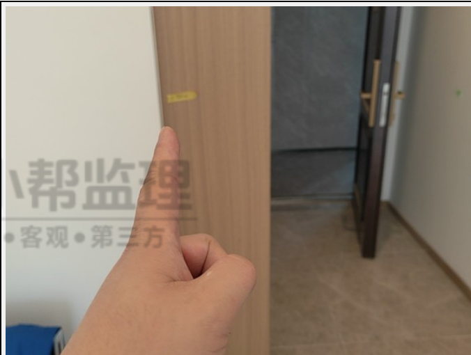
4、鞋柜和墙体之间打胶开缝
