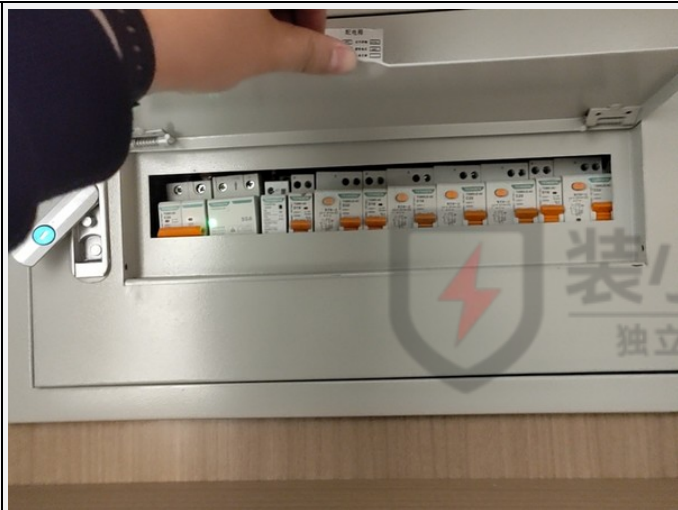
3、强电箱内部空开歪斜，且无标识
